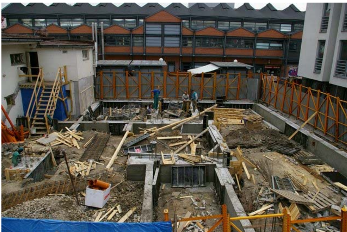
Obr. 01. Zvolen, Dostavba pasáže Wittmann Center. Pohľad na skúmanú plochu z juhu.
